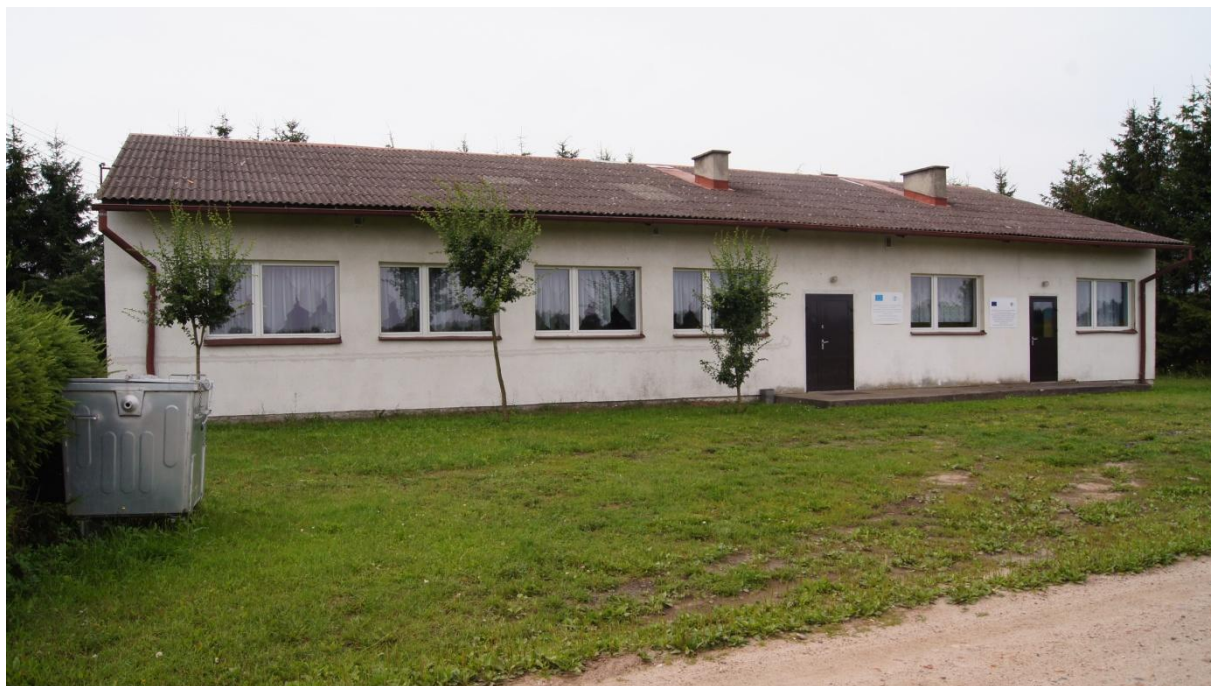
Świetlica wiejska w Zakrzewskiej Osadzie
