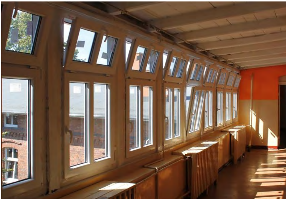
Rys.2. Wymiana stolarki okiennej w sali gimnastycznej ZS-CE Źródło: http://www.powiat-sepolno.pl/
