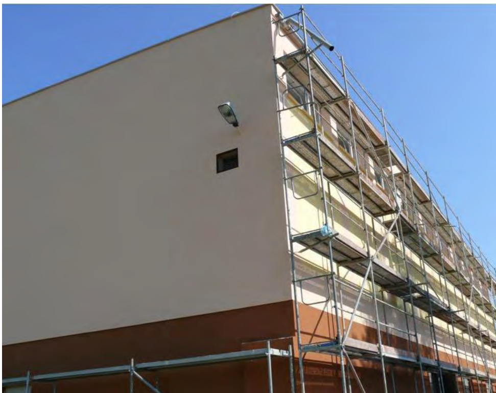
Rys.3. Docieplenie ścian zewnętrznych ZS-CE Źródło: http://www.powiat-sepolno.pl/
