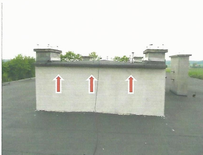
Fot. 16. Lokalizacja skrzynek lęgowych na elewacji wschodniej.
