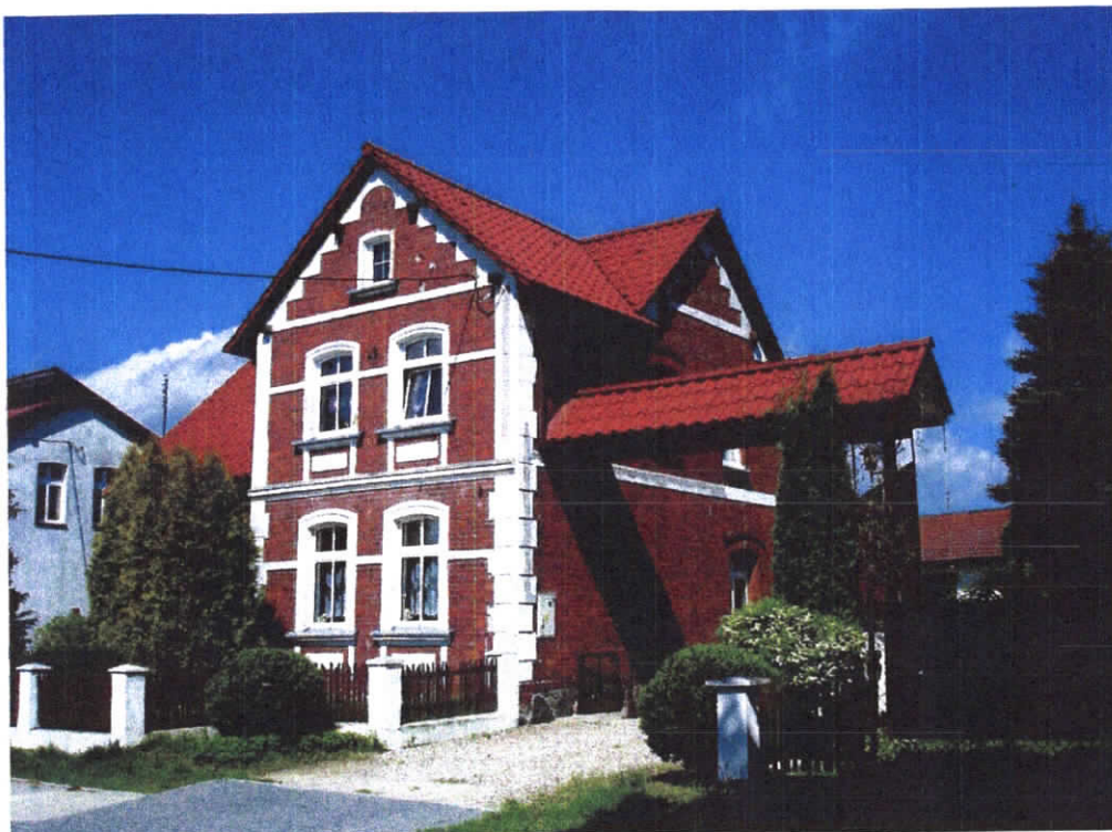
Widok od południowego wschodu
