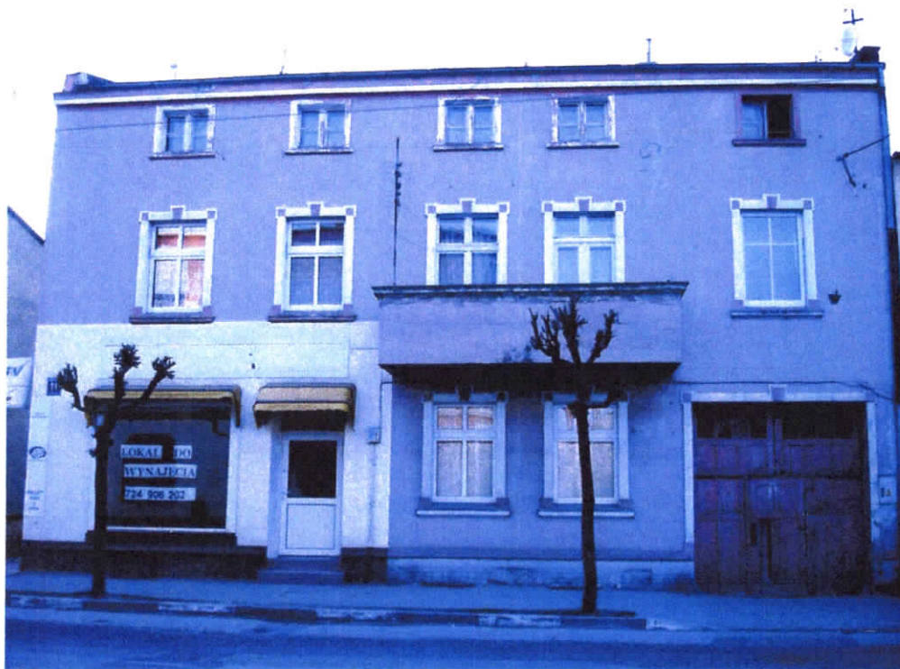
Widok od południowego wschodu
