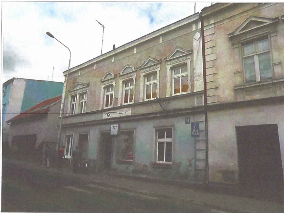
Elewacja frontowa, południowo - zachodnia.
