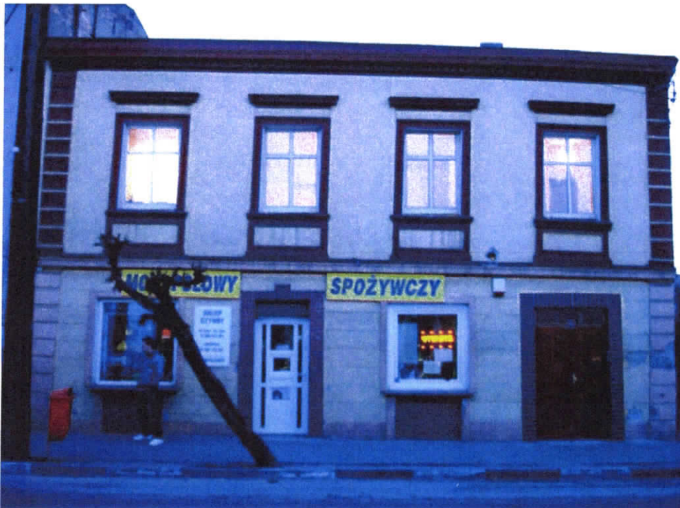
Widok od południowego wschodu
