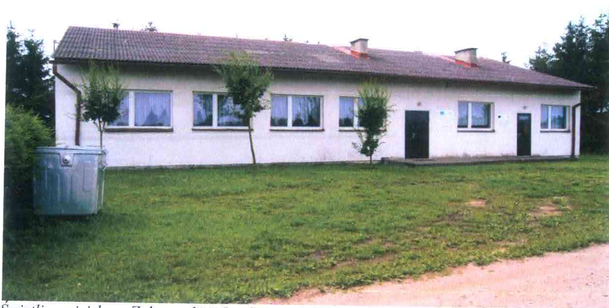
Świetlica wiejska w Zakrzewskiej Osadzie
